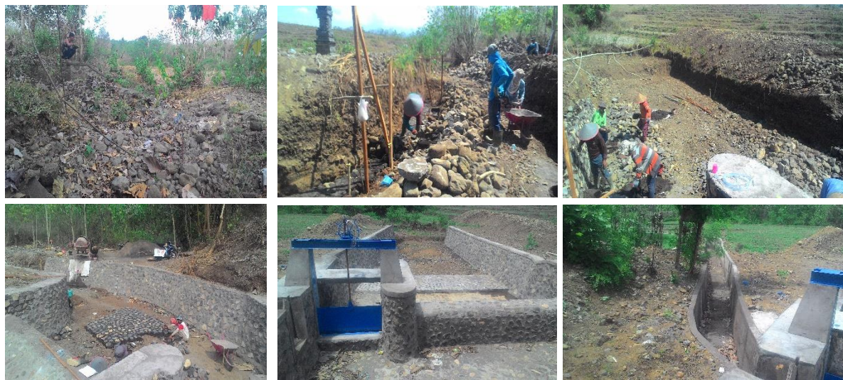
Pekerjaan Pembuatan Dam Parit
