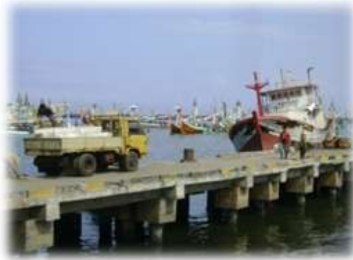
Gambar 7. 5 Kondisi Pelabuhan Perikanan di Pengambangan
