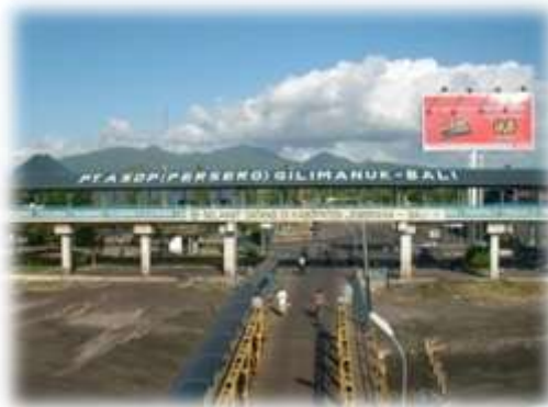
Gambar 7. 4 Kondisi Pelabuhan Penyeberangan Di Kabupaten Jembrana
